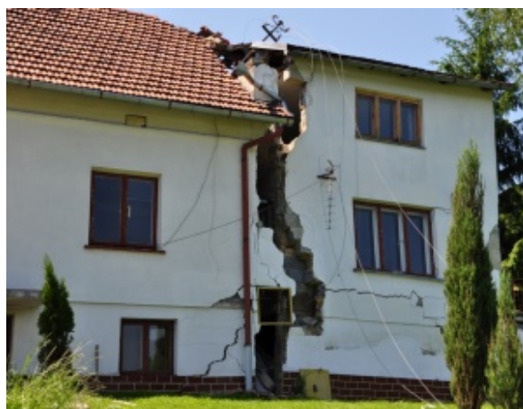
Fot. 1. Uszkodzenie budynku wywołane ruchami ziemi w powiecie strzyżowskim podczas powodzi w maju i czerwcu 2010 roku (zdjęcie dzięki uprzejmości starosty powiatu strzyżowskiego).
