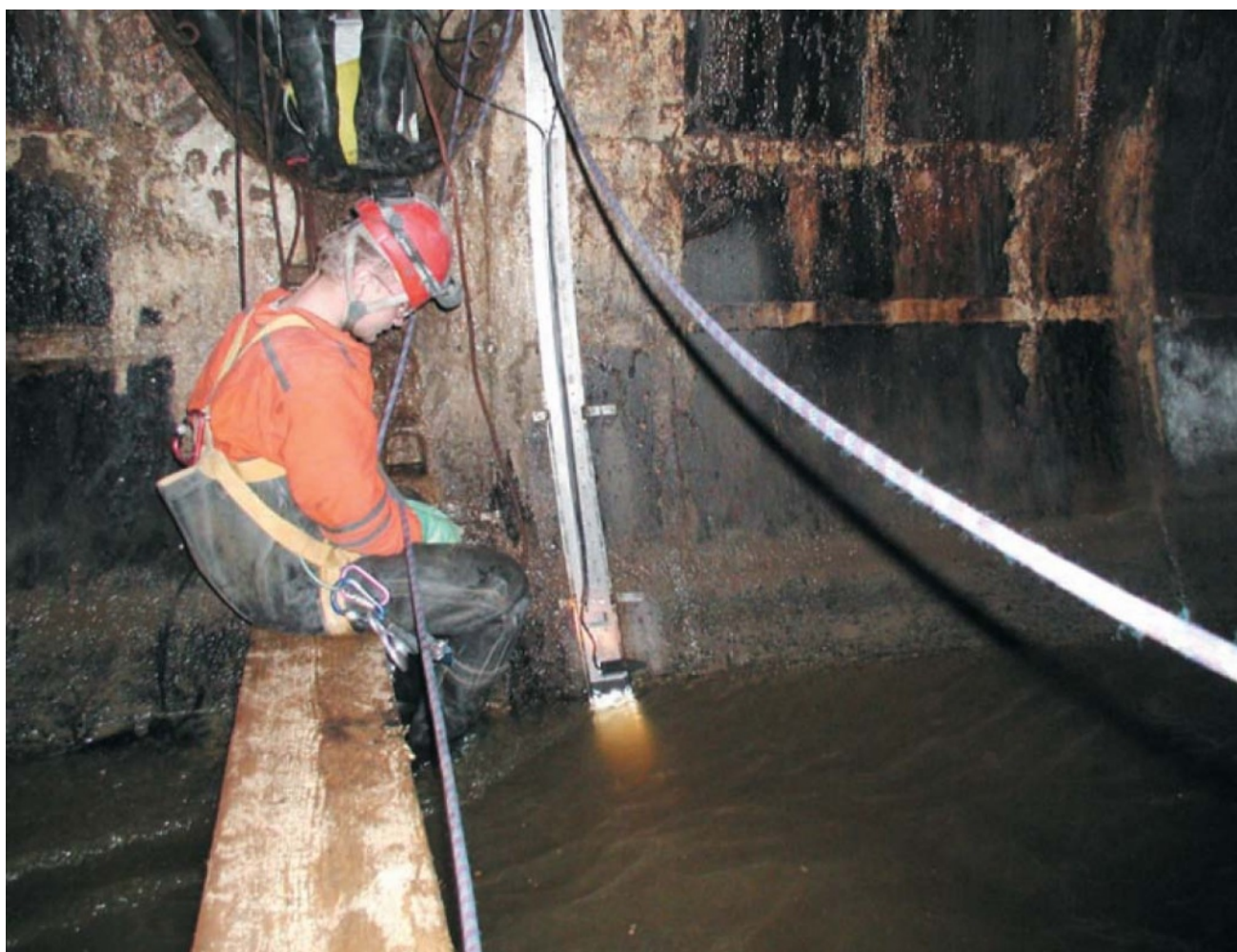
Fot. 1. Montaż czujnika ultradźwiękowego w kanalizacji.
