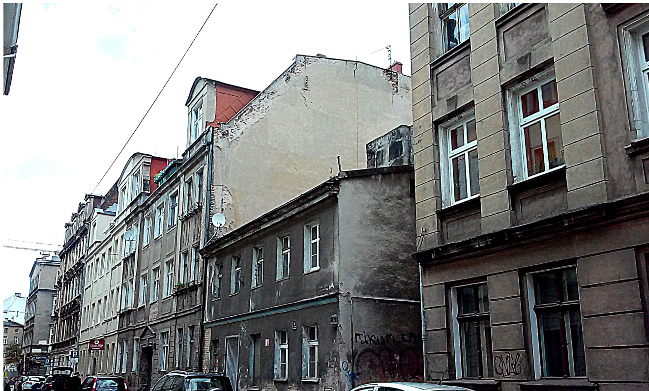
Fot. 1. Zaniedbana kamienica na ulicy Za Bramką jako stymulant koncentracji przestępczości, wykonane własne 08.09.2015
