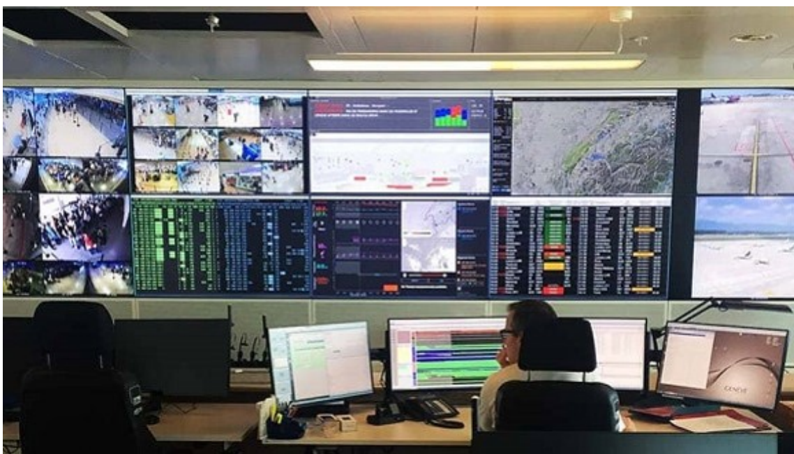
Rys. 1. Wnętrze Centrum Operacyjnego lotniska w Genewie.
